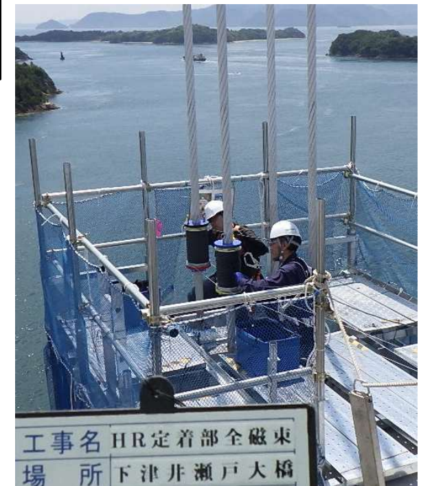
全磁束法調査を行う様子
